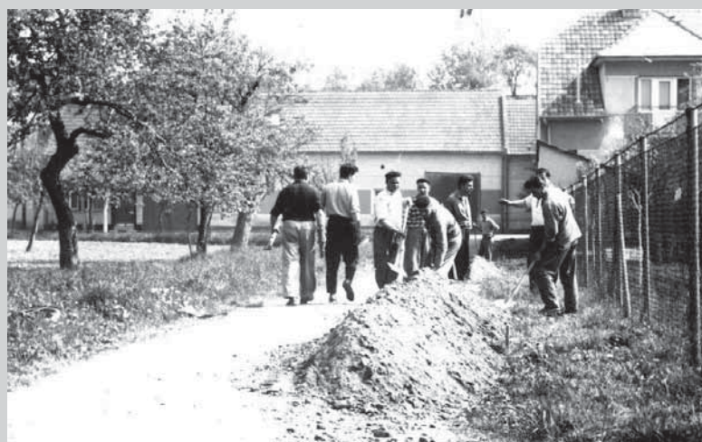
Budování chodníku k mateřské škole v květnu 1967.
