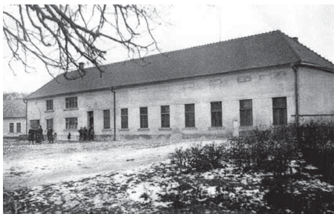
Hospoda na návsi, opravená v roce 1944
