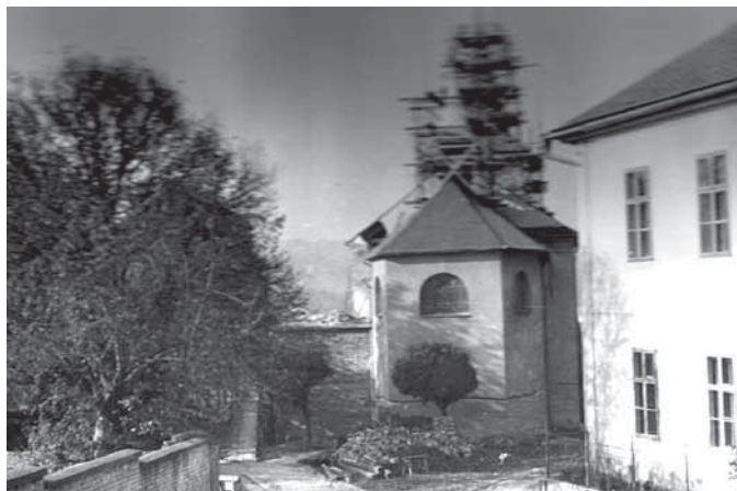
Oprava kostela v roce 1960
