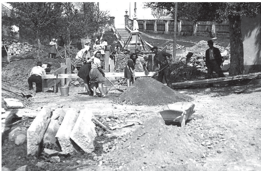
Stavba schodiště ke kostelu, rok 1947, při této příležitosti byla přemístěna socha sv. Antonína z levé strany schodiště na pravou, kde je dodnes
