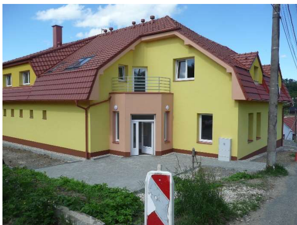
Pohled z jihovýchodu
